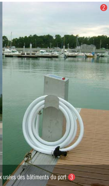
Saint Tropez (83) Réseau sous vide avec 7 points de collecte des eaux noires
