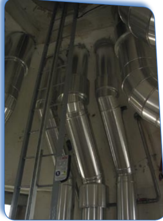
Régénération de château d'eau Limoges-Cercler (Vienne)
